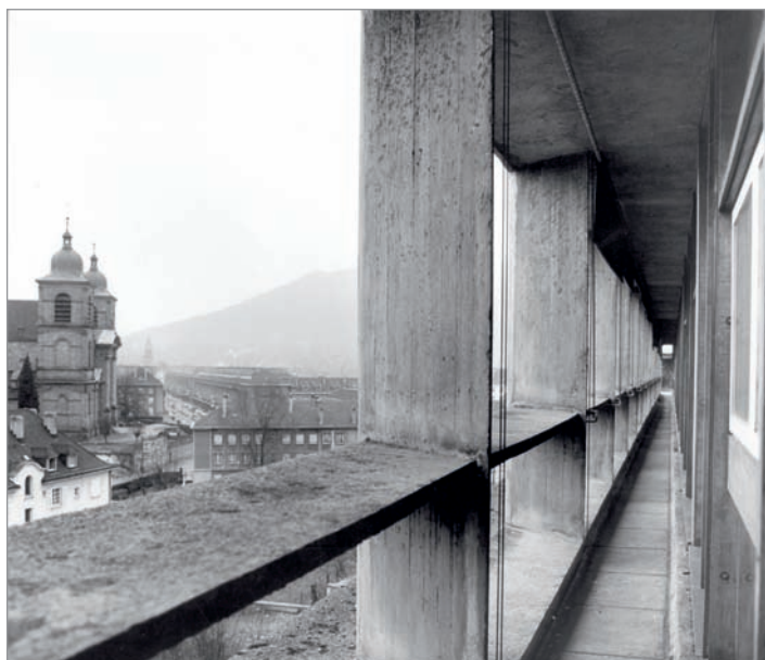
Manufacture à Saint-Dié. Vue de détail des brise-soleil de béton en façade principale. État d'origine. Photo : Pierre Joly et Véra Cardot L3 (6) 47
